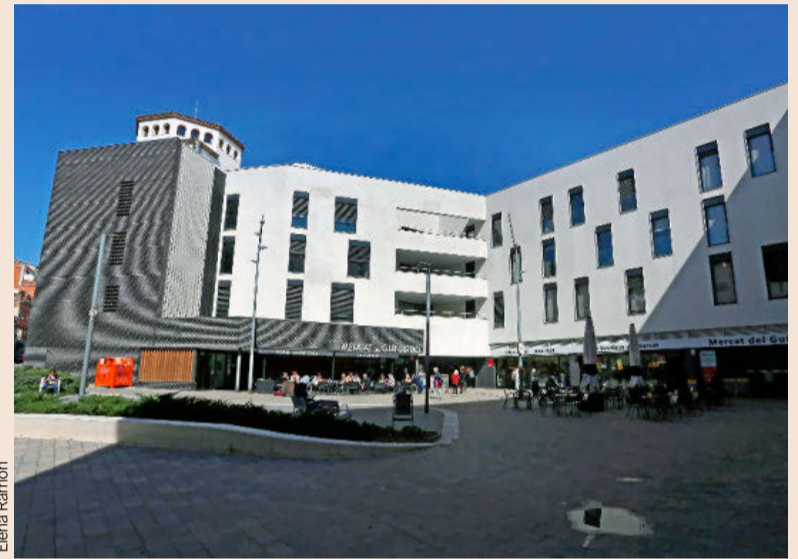
MERCADO DEL GUINARDÓ Liderado por los despachos Bayona Valero y Cantallops Vicente, el proyecto refleja la intervención en una isla que comprende 20.000 m 2 de equipamientos repartidos en seis programas.
