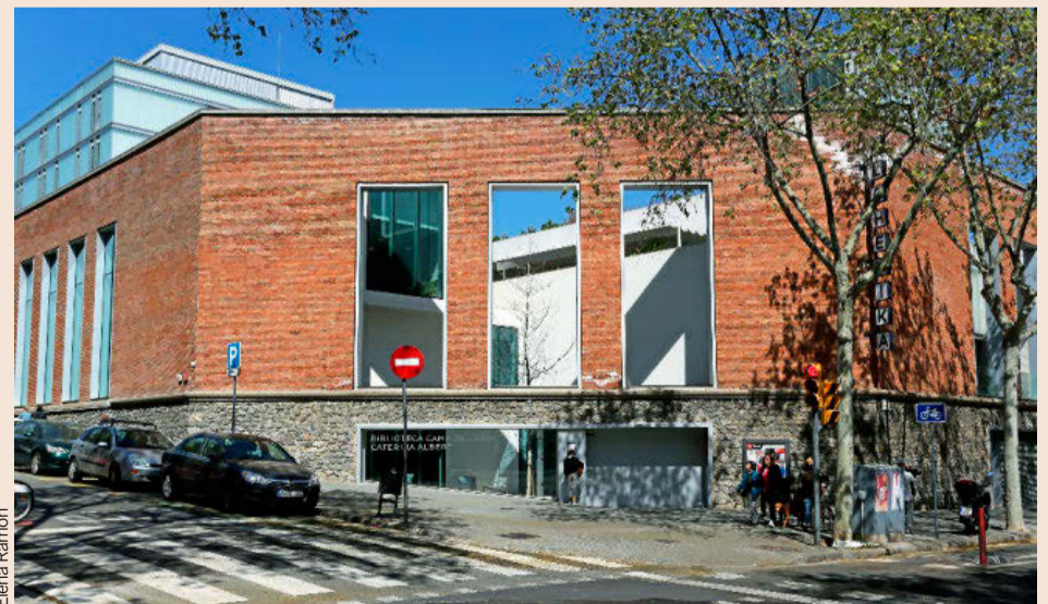
ALCHEMIKA - CAMP DE L'ARPA El despacho Oliveras Boix firma la reconversión de una de las dos islas del antiguo conjunto industrial Costa Font, donde hoy se ubican una biblioteca, una guardería, un centro de barrio y una residencia para personas mayores.
