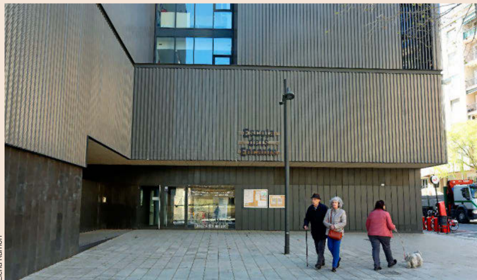
ESCOLA DELS ENCANTS “Una escuela que da respuesta a un programa de educación alternativo”. Así describe Xavier Bustos el proyecto de Roger Méndez, arquitecto del Área Metropolitana de Barcelona, ubicado en la aún incabada Plaza de las Glòries.
